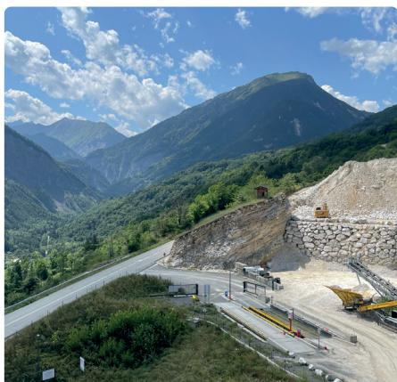
Nouvelle entrée/sortie des camions
