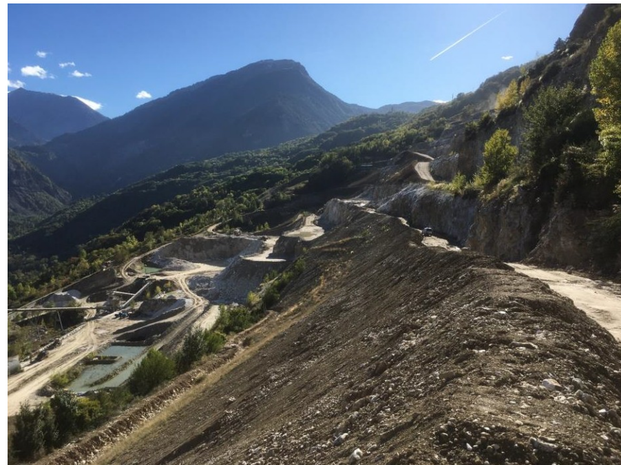
Réaménagement étages inférieurs (2019)
