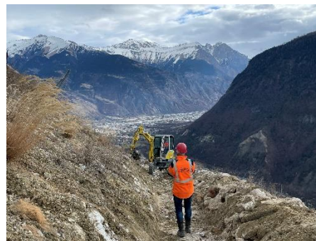
Banquettes intermédiaires pour canaliser l'eau
