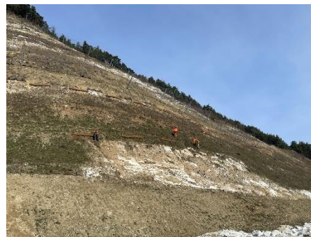
Substrat terreux et d'un couvert végétal
