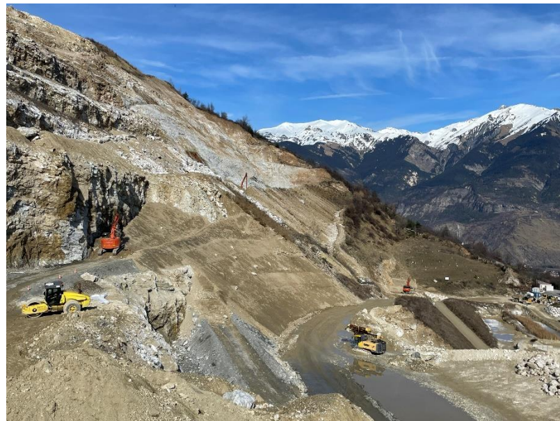
Etage inférieur : mix entre étages laissés apparents, pour favoriser les gîtes à chiroptères et remblayés,
