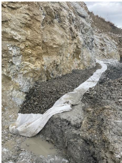
Réaménagement des étages et drainages liés
